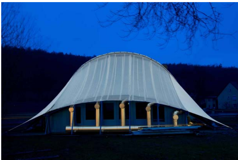
Südseite des Eisbär-Pavillons mit den solarthermischen Kollektorbahnen im Dach
